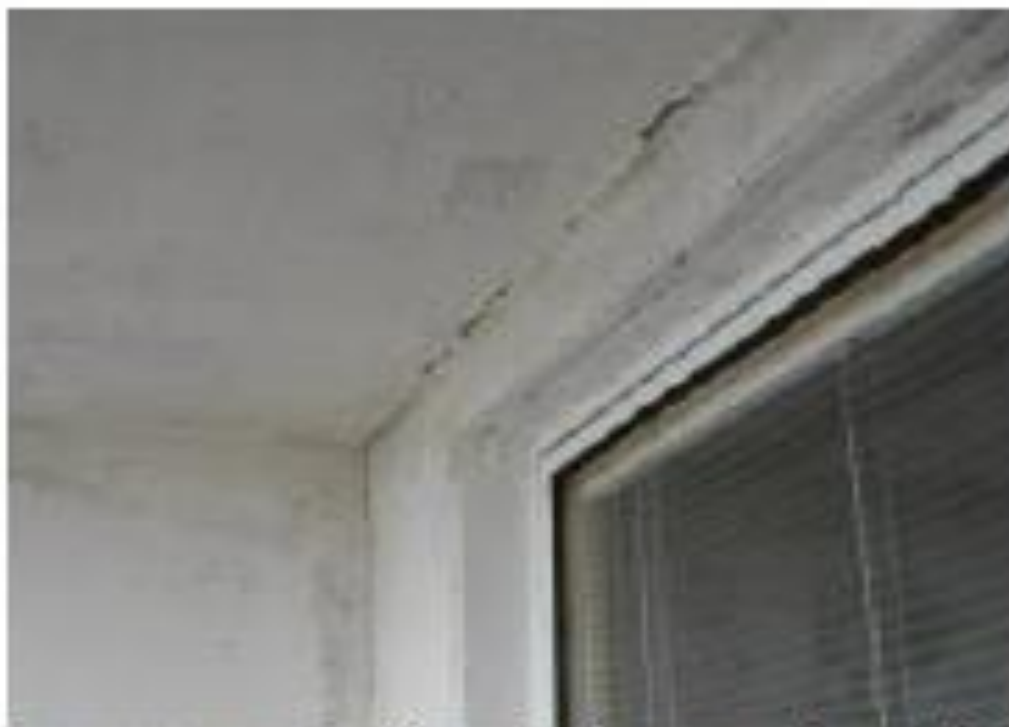
Obr. 4 Styk lodžiových dílců s odvodovým pláštěm
