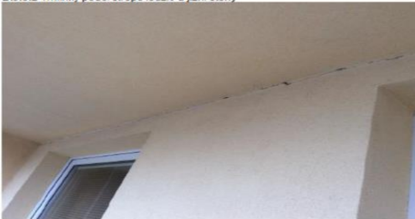
Obr. 5 Trhlínky ve fabionul stropu lodžie u jižní stěny
