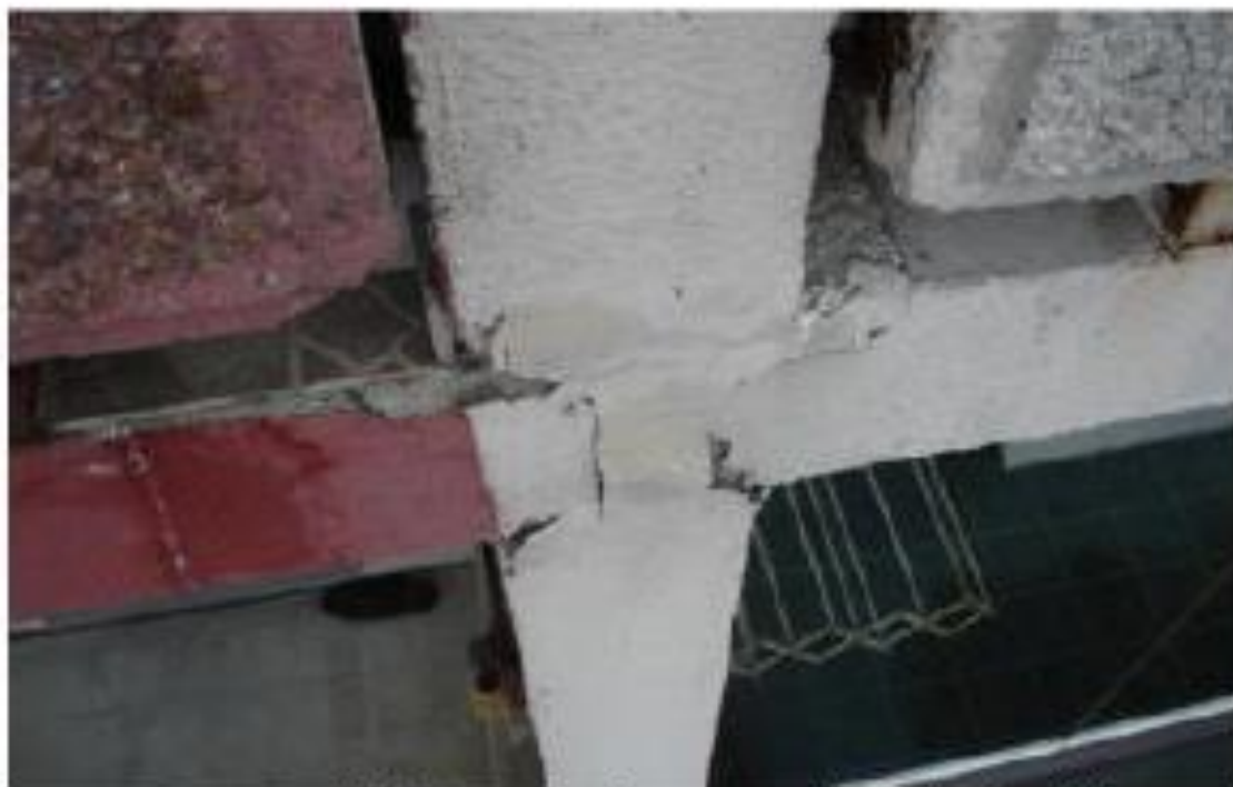
Obr. 7. Narušení styku stěnových a stropních lodžiových částí
