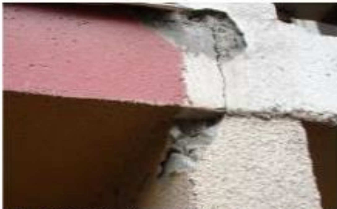
Obr. 5 Nedodržení montážních tolerancí – det. A
