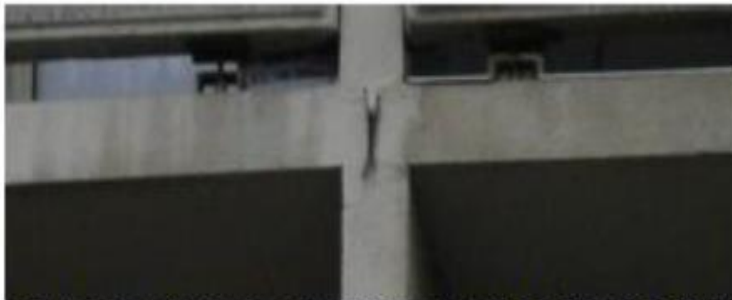
Obr. 6 Narušení styku stěnových a stropních lodžiových dílců
